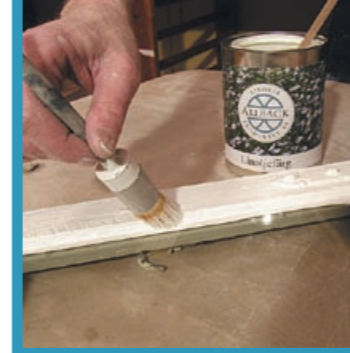
Målning av fönster
