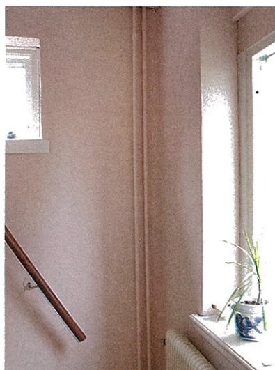
PÅ PUTS. Linusfärg målad direkt på en stenvägg.
